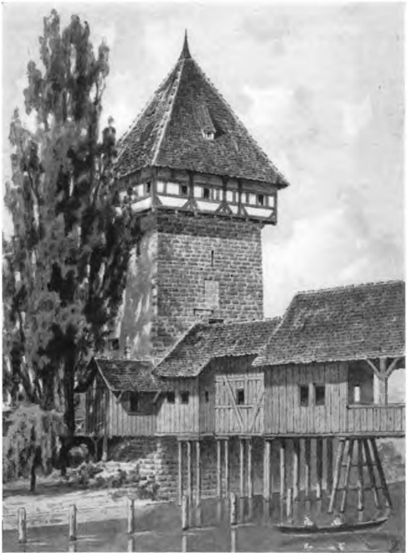
Die hölzerne und überdachte alte Konstanzer Rheinbrücke
