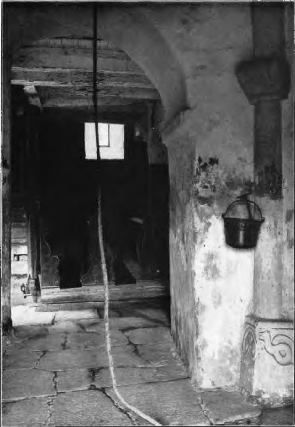
Turmhalle der St. Gangolfskapelle zu Neudenau
