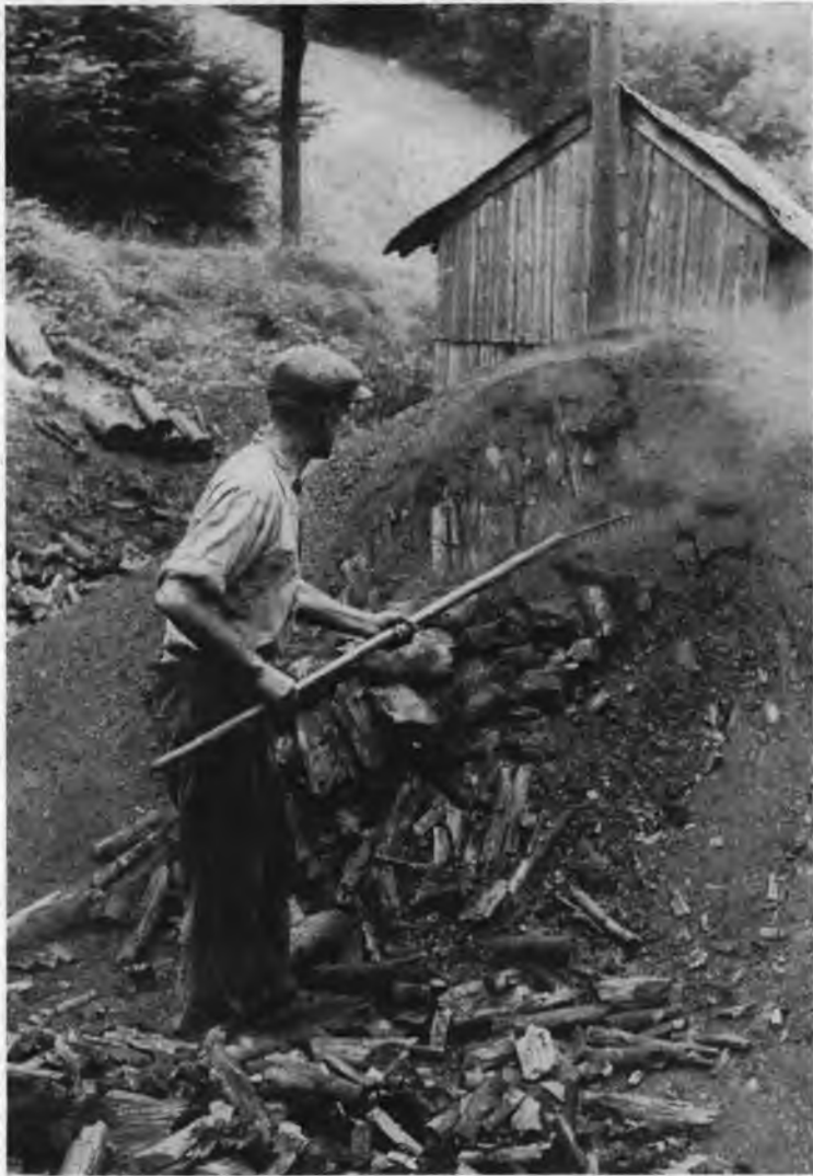
Bild 7 Entfernung des Sandmantels zur Prüfung der Kohle
