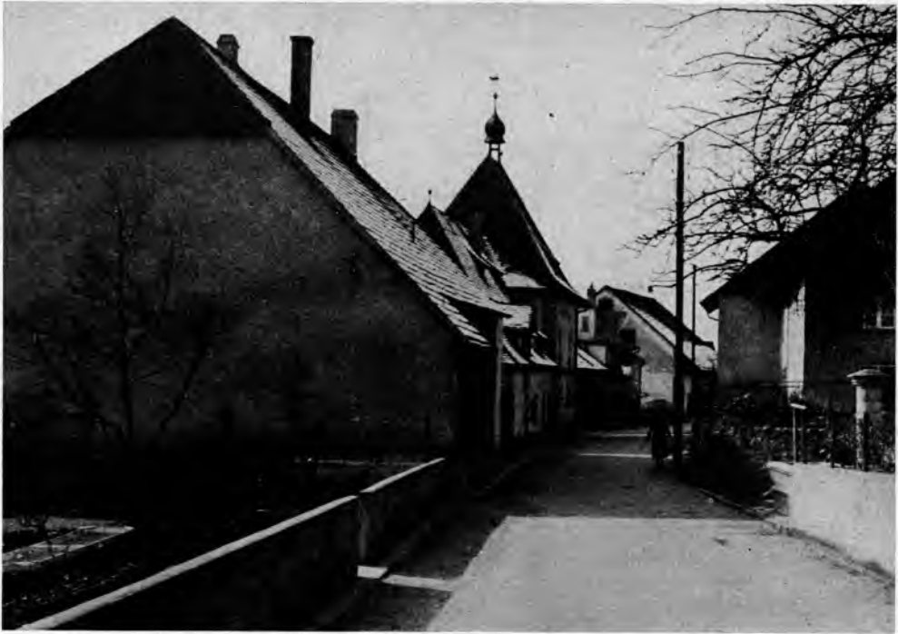
Die Ledergasse in Murg (alte Römerstraße)
