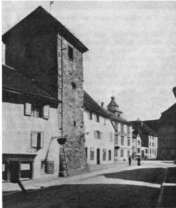
12. Schützenturm und alter Turm der Pfarrkirche
