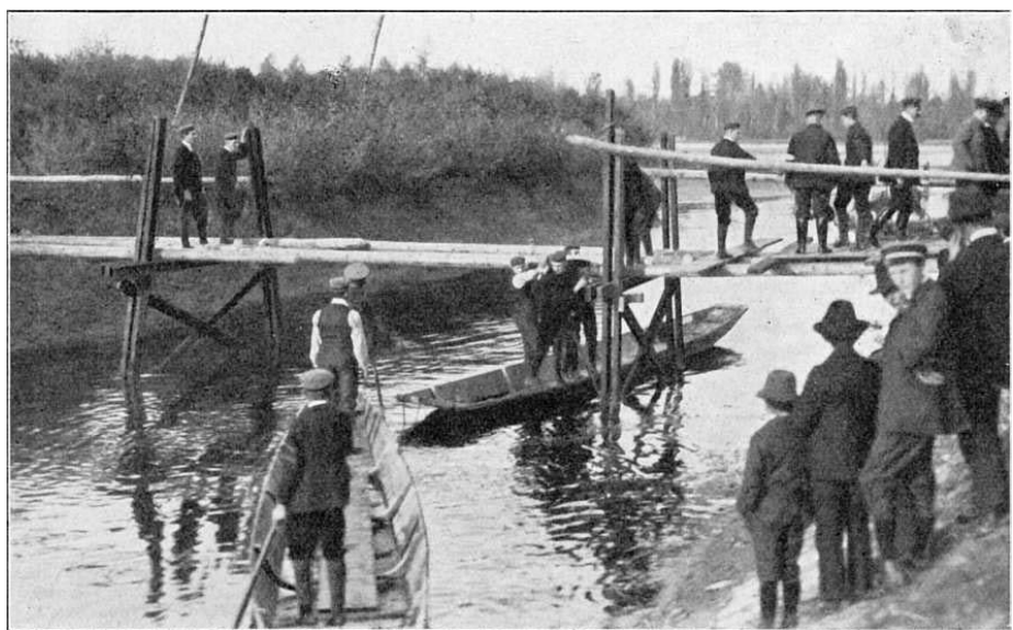
Brückenbau der Jugendwehr Schwarzach (Bezirk Bühl)
